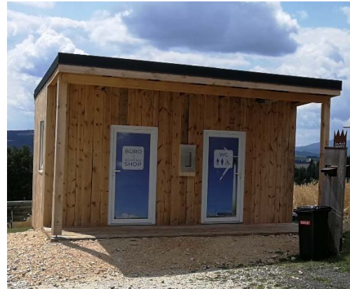
Neuer Sanitärcontainer mit Wasserentnahmestelle von be.pure
